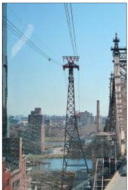
Links ein Einblick ins Schutzseilgeschäft. Rechts die New Yorker Tramway, die einen schnellen Zugang von Manhattan zum Roosevelt Island ermöglicht – und die neu mit 56 mm dicken Trag- und gespleisssten Zugseilen von der Gruppe Brugg-Tochter Fazer ausgerüstet wird. (Fotos: l. zVg., r. rb)
