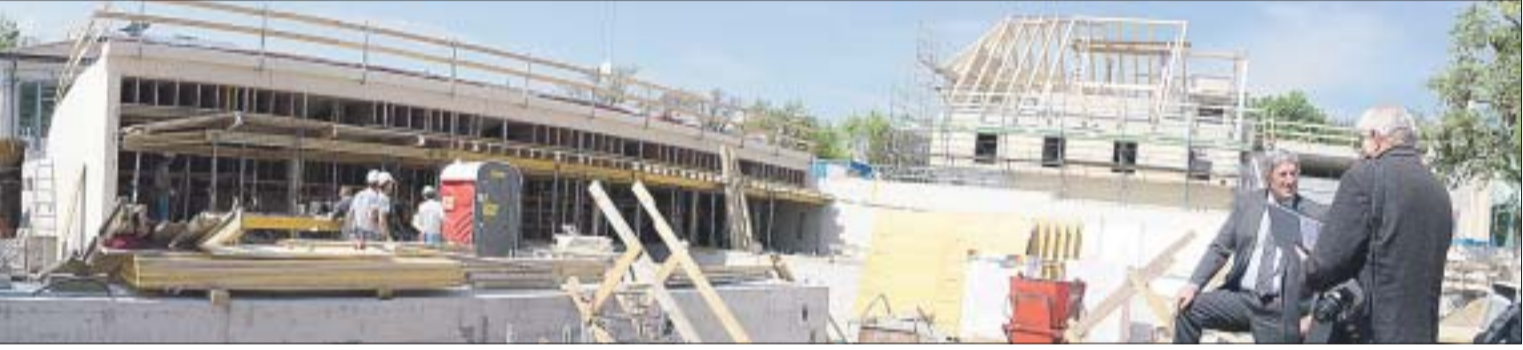
Der neue Dachstock des Hofsraatsgebäudes ist aufgerichtet. Wie VR-Präsident Hans-Rudolf Wyss vor dem Thermi-Becken erklärte, wird im Oktober 2011 die neue Anlage eingeweiht.
