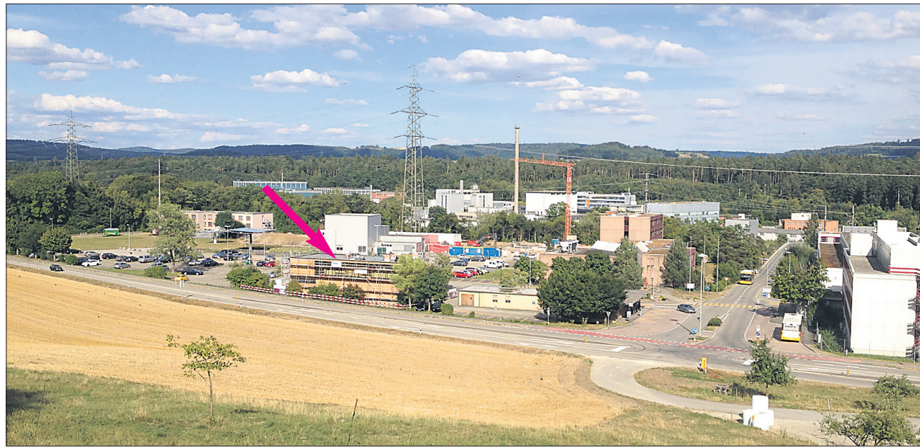
Der Innovationspark hat schon den ersten baulichen Niederschlag gefunden – mit einem Pavillon bei den Parkplätzen neben der PSI West-Einfahrt (Pfeil).
