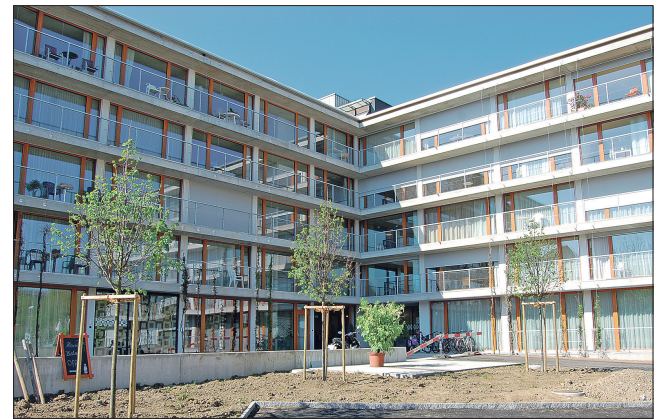
Drei Linden für den Lindenpark: So präsentiert sich nun der neue Hauptzugang nach zweieinhalb Jahren Bauzeit.
