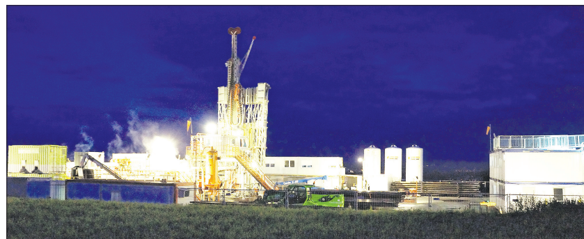
Bild vom Nagra-Bohrplatz in Bözberg, wo im Sommer 2020 der Untergrund für ein mögliches Atomendlager untersucht wurde – und zwar während 24 Stunden.
