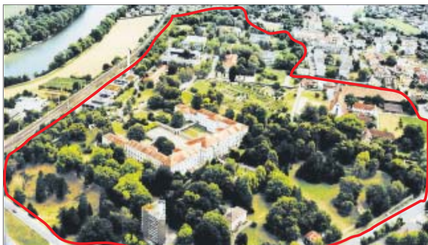
Grosses Gelände, grosse Bauten, grosser Sanierungsbedarf.
