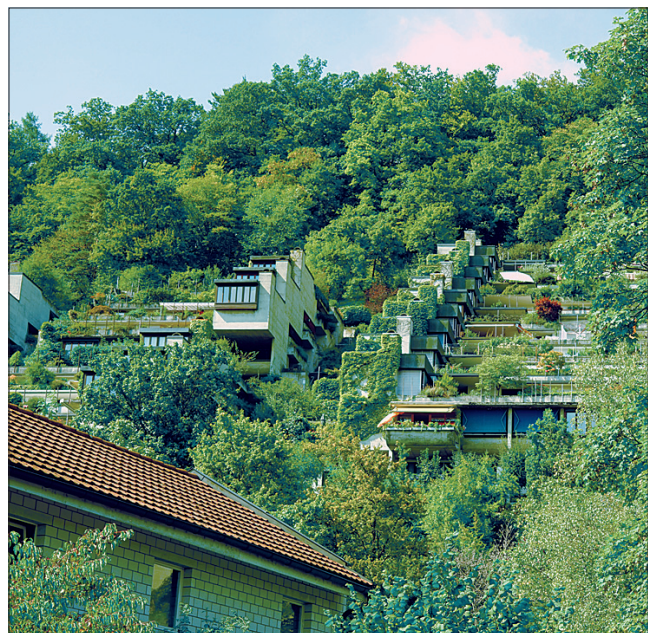
In der Mitte die erste Etappe mit den typischen Erkern, rechts und links davon die Etappen 2 und 3. Das aktuelle Bild zeigt eine mit dem Hang, dem Wald, der Umwelt verschmelzende Wohnform.
