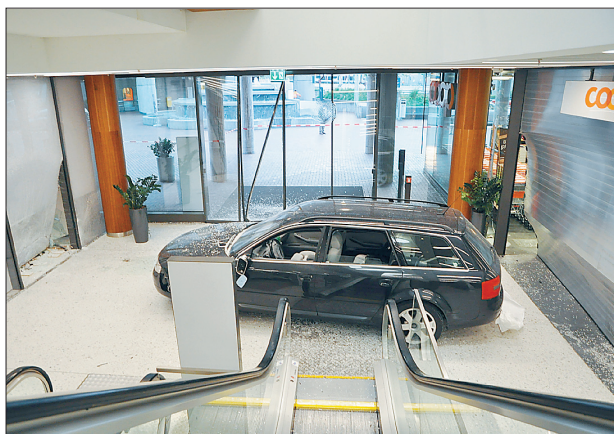
Das in Zürich gestohlene Rammbock-Auto im Neumarkt 2-Innenraum zwischen Coop (rechts) und dem Bijouteriegeschäft (links). Im Hintergrund die eingerammte Türe.
