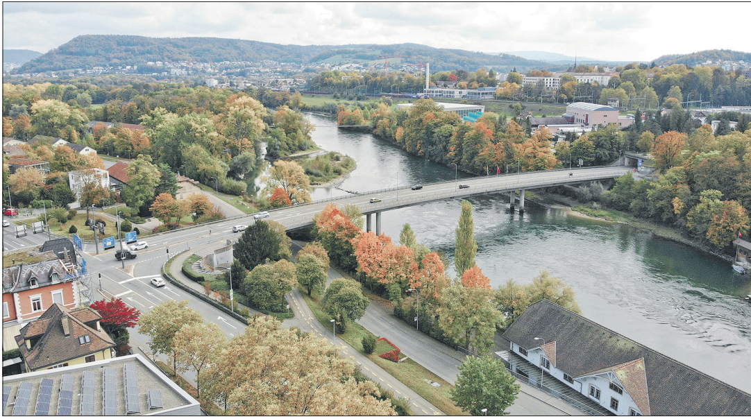
Die Mittlere Umfahrung aus der Vogelperspektive. Rechts: Zeitungsbeilage zur Eröffnungsfeier.
