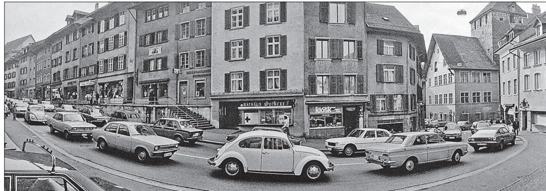
Das Bild in der «Katarakt»-Bar (Aufnahme von Hans Eckert) zeigt den Altstadt-Verkehrsalltag vor der Eröffnung der Mittleren Umfahrung.
