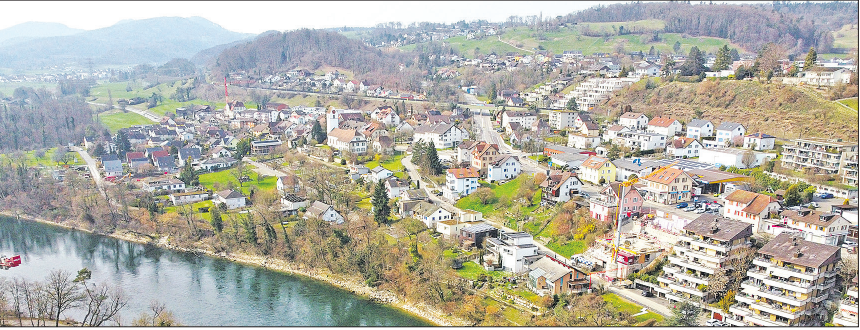
An der Immo-Messe dürften auch die neuen Terrassenhäuser, die sich derzeit an der Umiker Aarestrasse im Bau befinden, auf Interesse stossen – mehr dazu auf S. 5.
