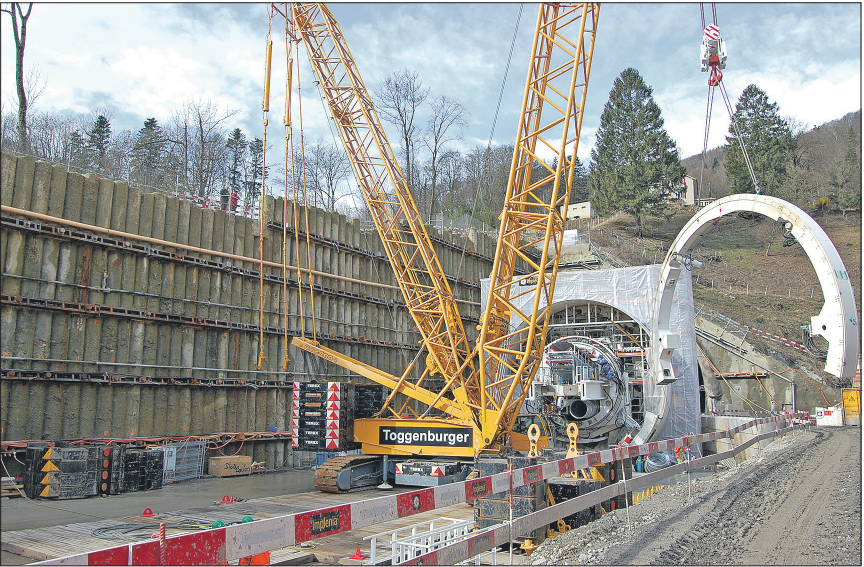
Am gelben Arm des Schwerlastkrans schwebt ein tonnenschweres Bauteil für den Tübbing-Erektor heran. Dieser ist Teil der gigantischen rollenden Fabrik, der TBM S1012 Bözberg, die derzeit montiert wird.
