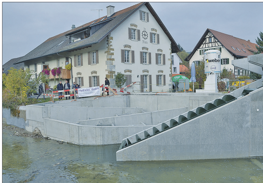
Links ein Blick auf die Wasserkraftschnecke, die auch Fische passieren lässt. Für den Aufstieg derselben wurde eine komplexe Anlage (rechts vor der alten Mühle) errichtet.
