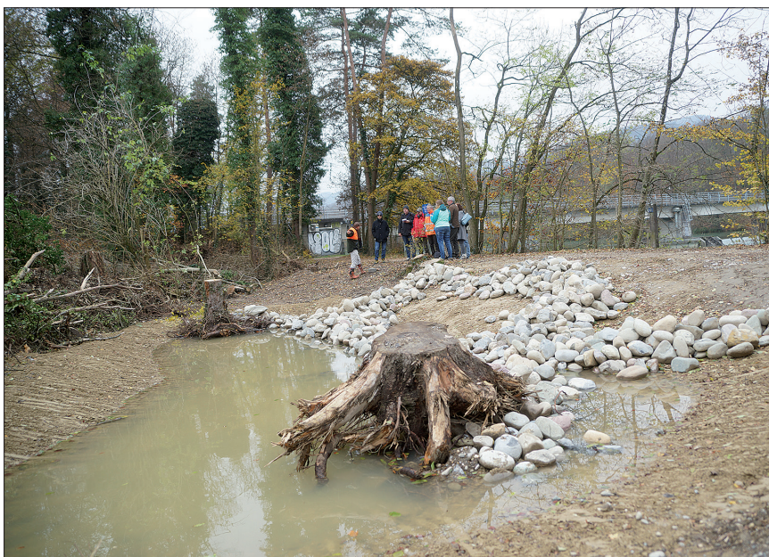
Im Bild ein neuer, in diesem Fall aber mit Kalkstabil abgedichteter Weiher – im Hintergrund die Verbindung über die alte Aare.
