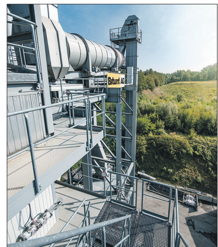
Asphaltmischwerk Biturit in Mülligen.
