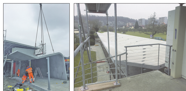
Montage der elegant geschwungenen Dachelemente.
