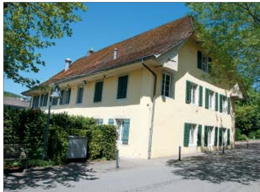
Der Entscheid ist gefallen: Das alte Thermi mit dem wunderschönen Gewölbekeller wird als Gebäudehülle erhalten und zum gehobenen Wellness-Center ausgebaut.
