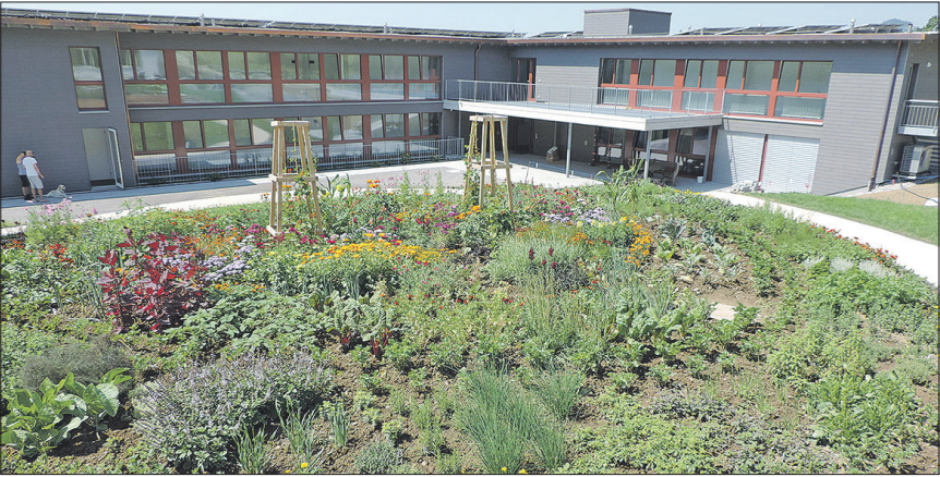
Der als L geformte Neubau schliesst zusammen mit den bestehenden Bauten einen Innenhof ab. Das ergab die Möglichkeit, einen Schaugarten mit 150 verschiedenen Pflanzen zu gestalten. Alle Pflanzen wurden in der eigenen Gärtnerei aufgezogen.
