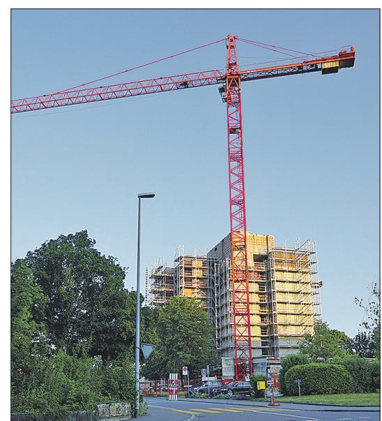
Blick auf das vollständig ausgehölte Hochhaus. Man ist im Zeitplan – im Juni 2018 können die Wohnungen bezogen werden.
