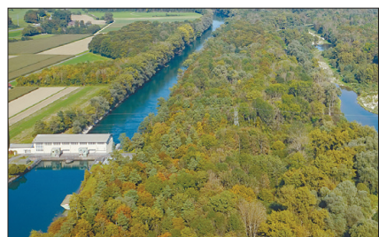
Blick auf das Turbinenhaus samt Aarekanal der Axpo Power AG, der Nachfolgerin der NOK. Rechts der Lauf der alten Aare.
