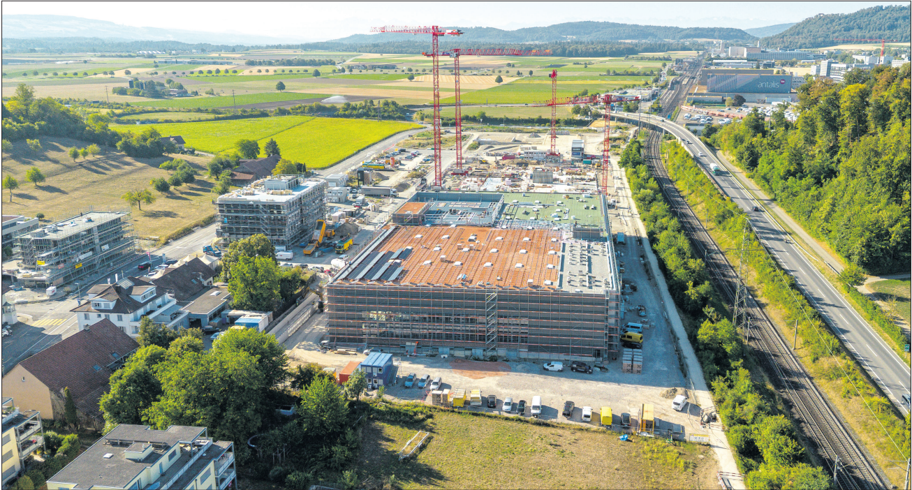
Mit dem Campus Reichhold bekomme der Aargau, freute sich der Windischer Regierungsrat an der Grundsteinlegung im Mai 2025, «keinen Leuchtturm der Industrie». Dieser nimmt nun immer mehr Gestalt an, wie auch die Drohnenaufnahme oben von Ende Juli zeigt (Foto: zVg Hiag).
