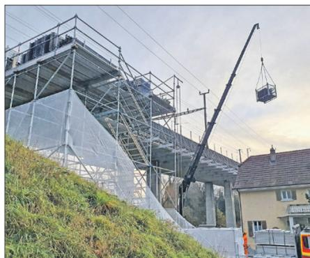
Die provisorische Auffahrt beim Unterwerk zum Gleis dient den Bauarbeiten an der Vorlandstützmauer, die verstärkt werden muss. Rechts: Gerüstarbeiten neulich im Bereich Bahnpark – für die Sanierung muss das Bauteam den gesamten Viadukt eingerüstet. Auch im Bereich der Aarauerstrasse, die vom 14. bis 19. Februar 2021 nur einspurig befahrbar sein wird.
