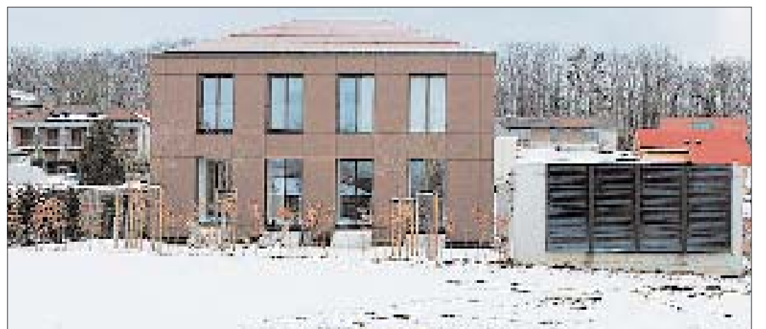
Symmetrie bringt Harmonie: Das Bosshard-Haus in Habsburg erfüllt den Minergie-P-Standard. Auch wegen der rechts am «Schopf» angebrachten Sonnenkollektoren, die für Warmwasseraufbereitung und Heizungsunterstützung die nötige Energie liefern.
