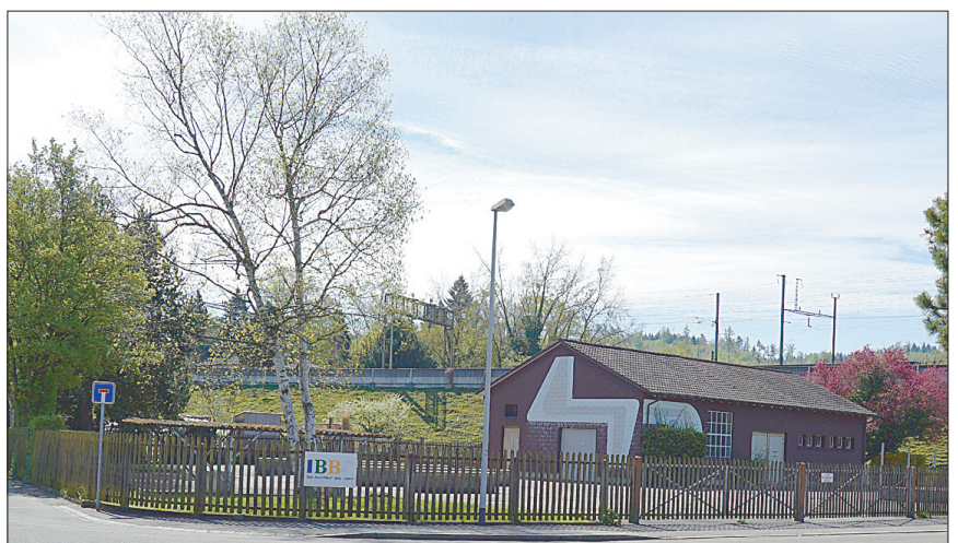
Hier, neben der Wohnüberbauung Bilander, sollen auf dem IBB-Land 88 Studenten-Wohneinheiten in Modulbauweise entstehen.
