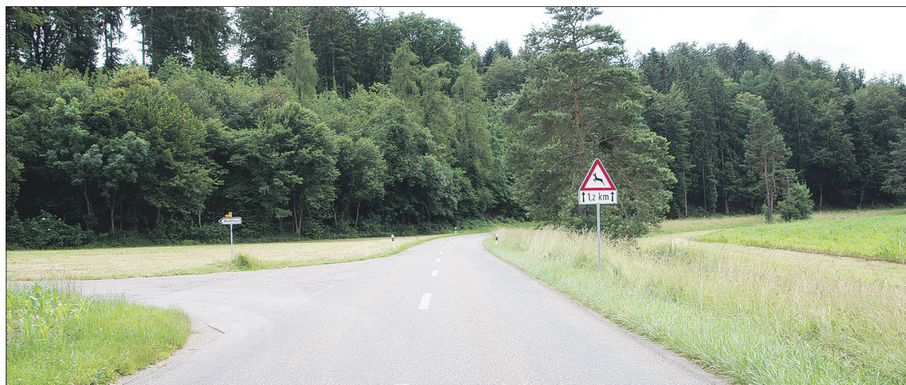
Zunächst wird bis nächstes Frühjahr der Radweg erstellt – und dann die Strasse saniert.
