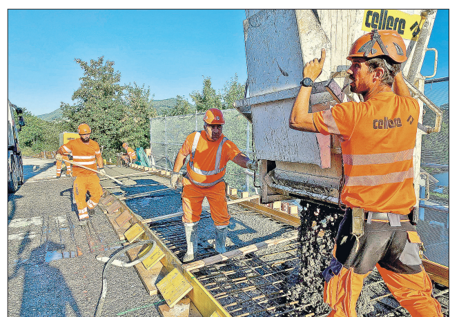
Die hitzeresistenten Cellere-Männer beim Betonieren des Gehwegs. Rechts: Peter Widmer (l.) und Stefan Hung beim neu beschichteten Stahltragwerk der Aarebrücke, wo innen (kleines Bild) nur noch die alten Sprenglöcher mit Mörtel verfüllt werden müssen.
