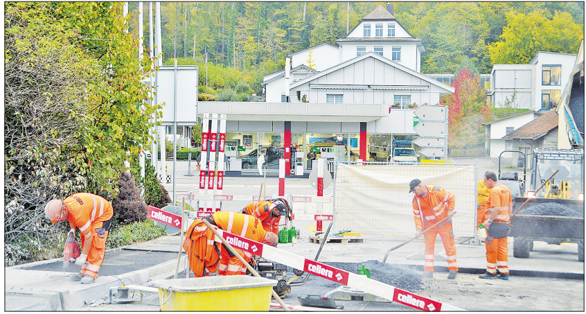
Die Bauarbeiter teeren ein letztes kleines Stück Strasse vor dem «Rössli»-Kreisel.
