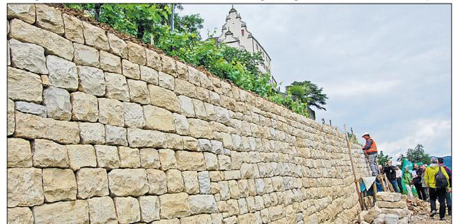
Aktuell genutzte Rebterrassen und kulturhistorisches Erbe zugleich: Die Trockenmauern in Kasteln – hier das soeben fertig gestellte Teilstück an der Hauptstrasse – werden saniert.
