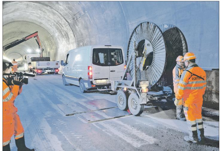
Grosser Bahnhof für den Tunnel: Der gestartete Einbau der Bahntechnik stiess auf grosses Medieninteresse – dieser umfasst neben dem Einzug der Leitungen ganz einfach sämtliche Anlagen, die der Tunnel benötigt: etwa Gleise, Fahrleitungen oder Sicherungseinrichtungen.
