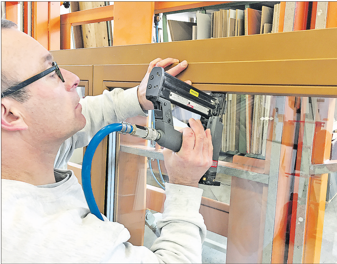
Christoph Noser, als Service-Fachmann täglich unterwegs in Unterhalts-Mission, verglast ein «blind» gewordenes Fenster neu.
