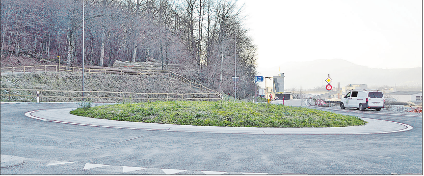
Der Kreisel Unterwerkstrasse wird womöglich mit einem Kunstobjekt verschönert.
