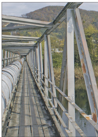
Förderbandbrücke: Jetzt noch morsch und rostig, demnächst aber wieder passierbar
