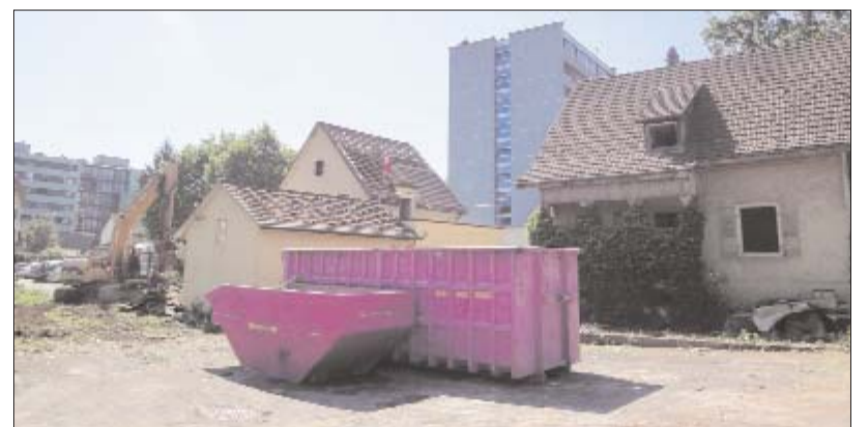
Mit dem Abbruch der Hauserstrasse 3 und 5 wurde diese Woche bereits begonnen.
