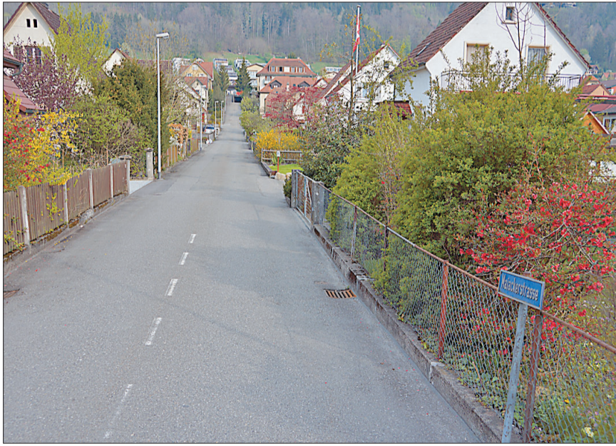
Maiackerstrasse Brugg: sanierungsbedürftige Werkleitungen.
