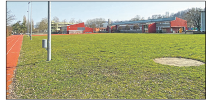
Neben dem neuen Schulhaus, der Doppeltturnhalle und dem Kindergarten ist auch die Neugestaltung des Areals inklusive Sportanlagen Teil des geplanten 34-Mio.-Projekts.
