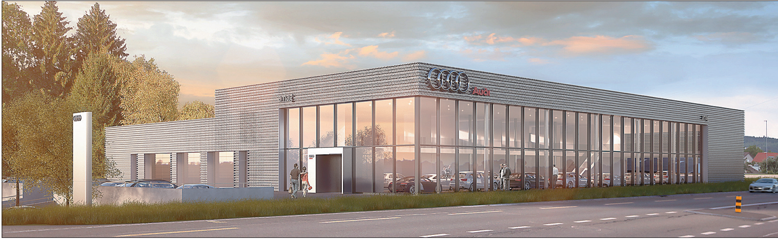
Das Audi Center der Hartmann-Architekten AG, Baden in der Visualisierung. Die Profillfassade aus speziell gelochtem Stahlblech entspricht den strengen Corporate Identity-Vorschriften von Audi Deutschland.
