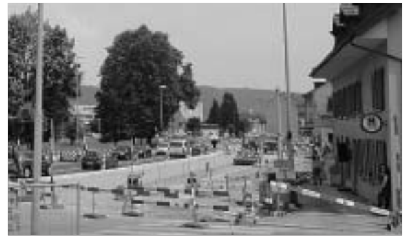
Quasi kurz und schmerzlos soll er erfolgen, der Belags-einbau von Harmonie bis Kreisel Dorfstrasse
