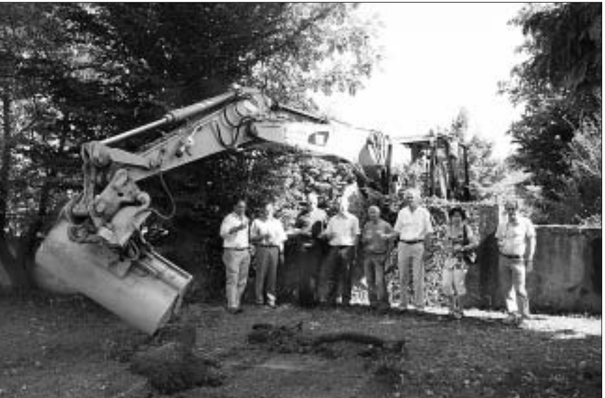
Auf dem Bild hat der Bagger bereits gewirkt; die Kirchenpflege- und Baukommissionsmitglieder samt Gemeindegliedern stossen aufs Werk an.
