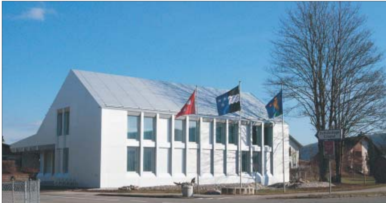
Die Aussenhülle aus Aluminium fügt alt und neu zu einem Ganzen zusammen.
