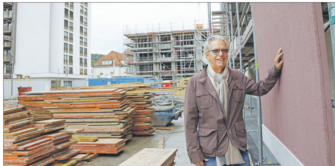
«Die viergeschossigen Bauten werden olivengrün, die dreigeschossigen weinrot – wie bei dieser Musterfläche hier», erklärt Livio Plüss – wobei Oliven und Wein für gepflegten Genuss im Alter stünden.
