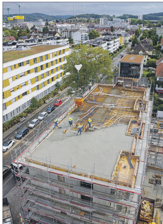
Auf dem Gelände des ehemaligen Alterszentrums sind – quasi als letzter Mosaikstein des Mammutprojekts «Akkord» – vier Neubauten mit 55 Seniorenwohnungen emporgewachsen. Nun wurde die letzte Decke betoniert (Bild) – dies im sogenannten Haus L, wo die Gewerbeflächen im Parterre mittlerweile an die Süssbach AG vermietet worden sind.
