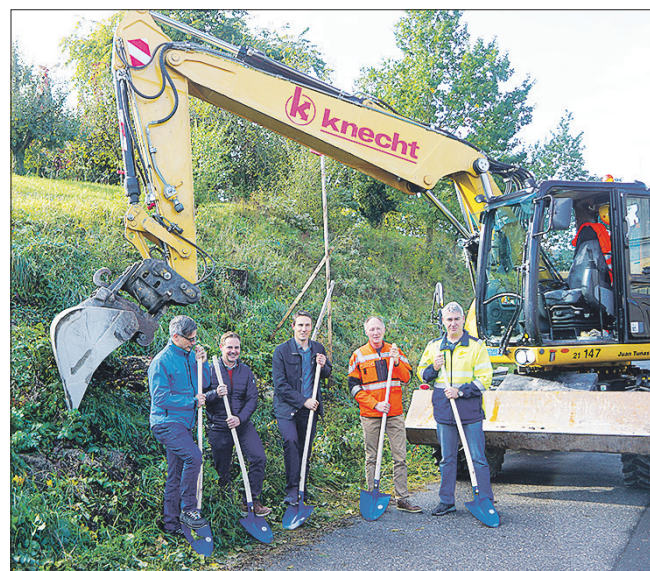
Baubeginn Stufenpumpwerk: Zum Spatenstich traten an (v.l.): Felix Kreidler (Geschäftsleiter Ingenieur- und Servicedienste IBB), Stefan Obrist (Präsident ReWa Birrfeld), Matthias Treier (Gemeinderat Windisch), Roman Maeder (Geschäftsbereichsleiter K. Lienhard AG, Ingenieure) und Andi Bruder (Leiter Wasserwerk Windisch).
