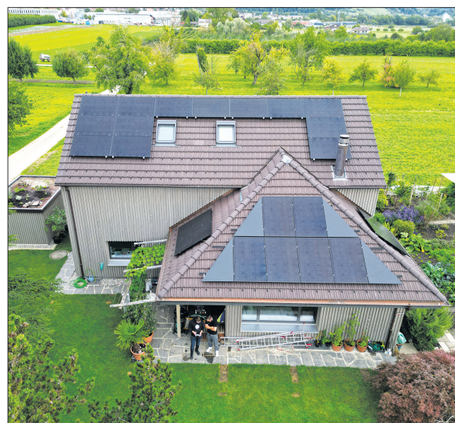
Das Bild zeigt ein Beispiel einer Powerlogic-Solaranlage in Veltheim.
