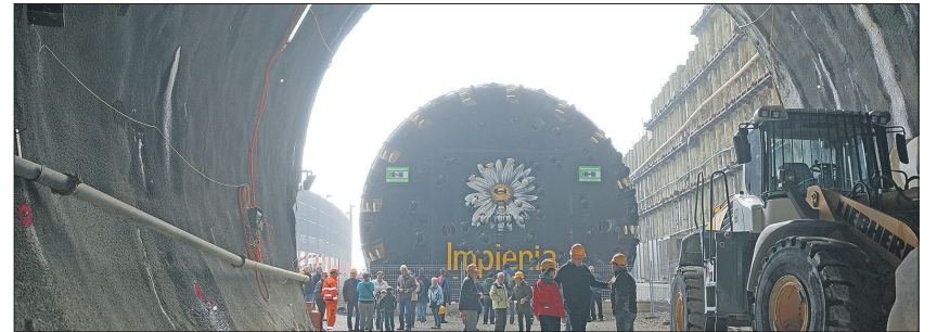
Die Besucher nutzten die Gelegenheit, ebenda durchzuspazieren, wo Ende 2020 Züge rollen werden (bis 2022 wird dann der alte Tunnel zu einem Dienst- und Rettungsstollen ausgebaut).
