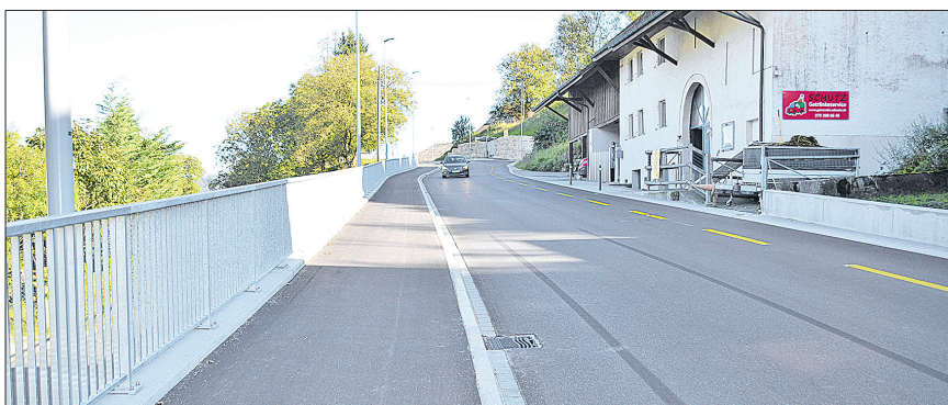
Der verbreiterte und sanierte Abschnitt der Rinikerstrasse mit Trottoir, neuem Belag und Velostreifen.
