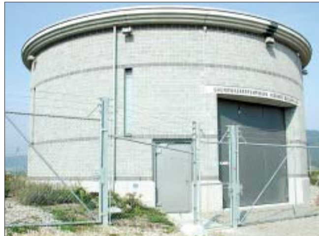
Grundwasserpumpwerk Vorhard auf dem Villigerfeld. (Foto ibb)
