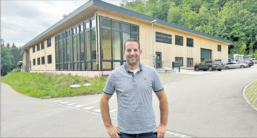
Da, wo vorher die Kompostieranlage war, floriert jetzt das Gewerbe: «Es fehlt nur noch die Sperrholzfassade», sagt Christian Suter vor dem neuen Standort. Hier sind neben seiner Firma mittlerweile auch die Gasser Bauunternehmen GmbH, die Garage Rauber sowie die Stöckli Spenglerei & Flachdachbau GmbH tätig.
