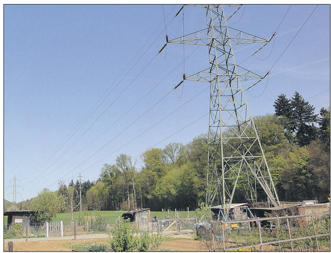
Wie lange es wohl geht, bis die alte Leitung weg ist?
