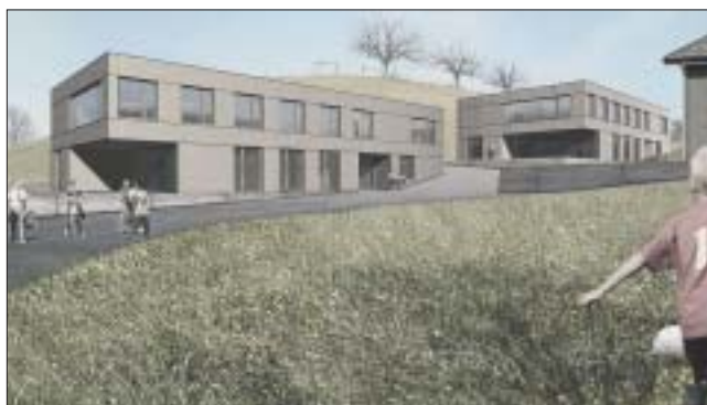
Die beiden in den Hang gesetzten Wohnbauten für Knaben bilden mit dem bestehenden Knabenhaus (rechts) eine Einheit.
