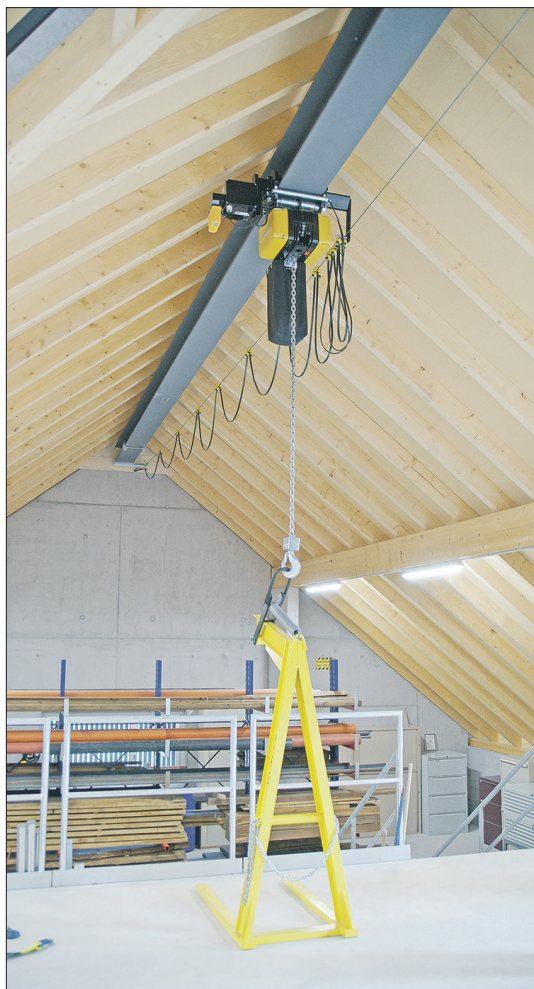
«Eine richtig schöne Zimmermannsarbeit», meint André Jacquat im Werkhof-Estrich mit Blick an die Decke. Ins Auge springt da der erneuerte Kreuzfirst, ein volumengeschütztes Element der früheren Feldweibelhaus-Scheune. Raffiniert zudem: Der Firstbalken wurde mit einem Stahldachträger ersetzt, der auch als Kranbahn funktioniert. So dass der Kran das, was im Obergeschoss gelagert werden soll, von unten durch die Decke (Bild rechts) hochhieven kann.
