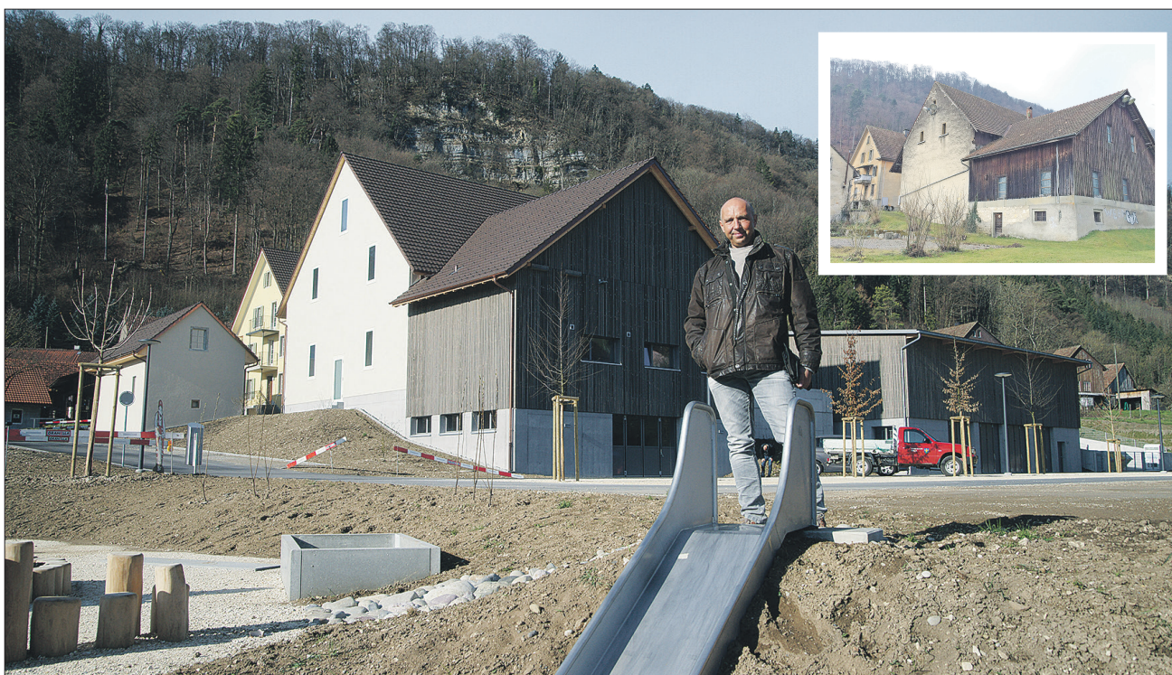
«Auf die Einweihung hin wird er fertig, der neue Spielplatz», sagt André Jacquat mit der neuen Anlage im Hintergrund (kleines Bild: Ansicht im 2014). Der Werkhof sei schon seit gut einem halben Jahr in Betrieb, man habe den Anlass aber nicht in leeren Hallen, sondern «mit Leben in der Bude» begehen wollen, so Jacquat.
