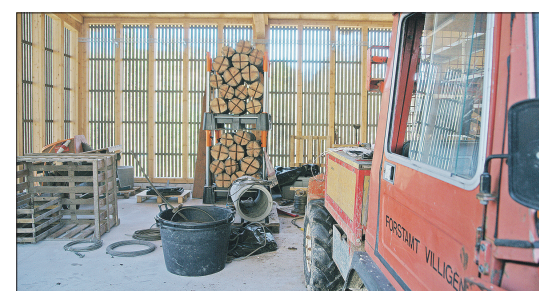
Diese Ansicht zeigt Mini-Ramp, Entsorgungsplatz und Trotte-Parkierung. Rechts: Im frostsicher temperierten Annexbau wirkt auch das Forstamt – hier springt die offene, der guten Durchlüftung dienende Lattenverschalung-Fassade ins Auge. Diese – vorbewittert und aus einheimischer Tanne – prägt das Erscheinungsbild des ganzen Ensembles.
