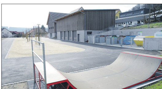
Diese Ansicht zeigt Mini-Ramp, Entsorgungsplatz und Trotte-Parkierung. Rechts: Im frostsicher temperierten Annexbau wirkt auch das Forstamt – hier springt die offene, der guten Durchlüftung dienende Lattenverschalung-Fassade ins Auge. Diese – vorbewittert und aus einheimischer Tanne – prägt das Erscheinungsbild des ganzen Ensembles.
