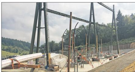
Hier werden die 380kV-Erdkabel zum Riniker Übergangswerk geführt, von wo aus sie mit Zugmaschinen durch den Rohrblock gezogen werden. Im Bild sieht man die bereits eingezogenen Kabel heraus-schauen, parat für den Anschluss an die Freileitung.
