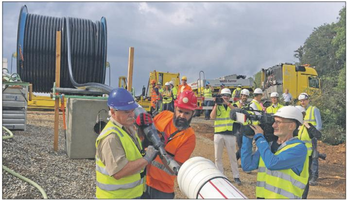
Die Spannung steigt: zum einen von 220 auf 380 Kilovolt – zum anderen bei den Medien auf der Bilderjagd, als am Dienstag das achte von insgesamt zwölf Brugg Cables-Kabeln von der 40-Tonnen-Rolle lief und eingezogen wurde.
