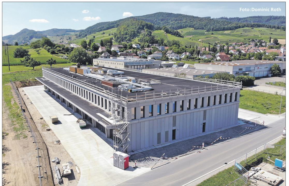
Nach 21 Monaten Bauzeit und verbauten 10500 Kubik Beton sowie 12500 Kubik Kies und Sand bietet das gelungene Werk nun eine multifunktionale Plattform fürs Gewerbe. Ins Auge springen die grossen Toröffnungen an der Süd- und Nordfassade mit dem auskragenden Vordach. Im Obergeschoss wird die Fassade aus fein strukturierten Betonelementen durch gleichmässig angeordnete Fensteröffnungen gegliedert.
