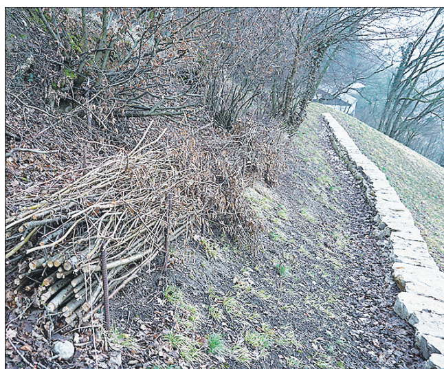
24 Laufmeter Trockenmauer – insgesamt 29 Tonnen Steine aus dem Steinbruch Mellikon samt Hinterbau – sind am Bruggerberg letzte Woche eingeweiht worden (links). In einer ersten Etappe wurden die Mauer rechts und das herabrollende Steine aufhaltende Faschিংengeflecht (rechts) erstellt.
