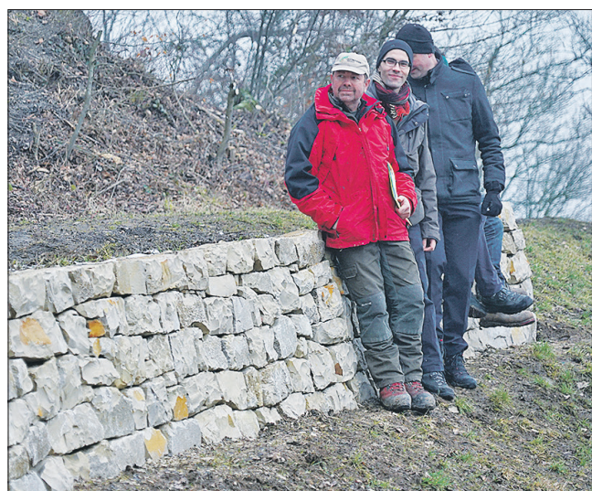
24 Laufmeter Trockenmauer – insgesamt 29 Tonnen Steine aus dem Steinbruch Mellikon samt Hinterbau – sind am Bruggerberg letzte Woche eingeweiht worden (links). In einer ersten Etappe wurden die Mauer rechts und das herabrollende Steine aufhaltende Faschিংengeflecht (rechts) erstellt.
