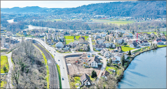
Die Ausgrabungsstelle im Steinacher.
