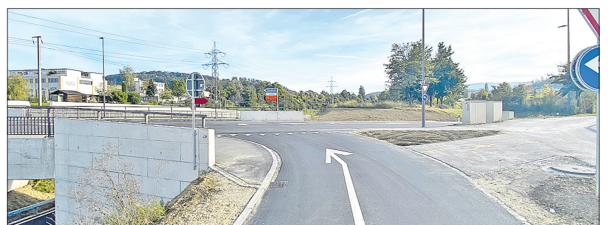
Schon speziell, wenn ein Gehweg die Ausfahrt einer grün signalisierten Strasse quert.
