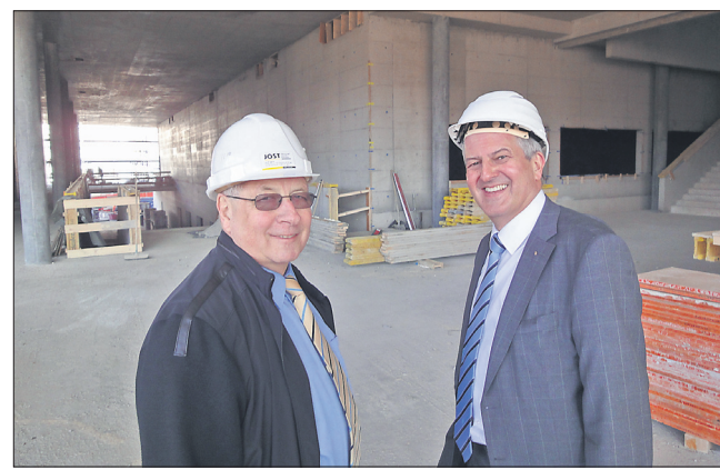
Andreas Bürgi (l.) und Anton Lauber vor dem im Rohbau fertigen Campus-Saal. Laut Lauber gehe es für den Verein nun darum, seine Position punkto Saal-Marketing zwischen Campus-Saal Betriebs AG und Brugg Regio zu finden. Klar sei: «Gerade für schweizweite Anlässe muss man jetzt anfangen, die Werbetrommel anzuklopfen», so Lauber.
