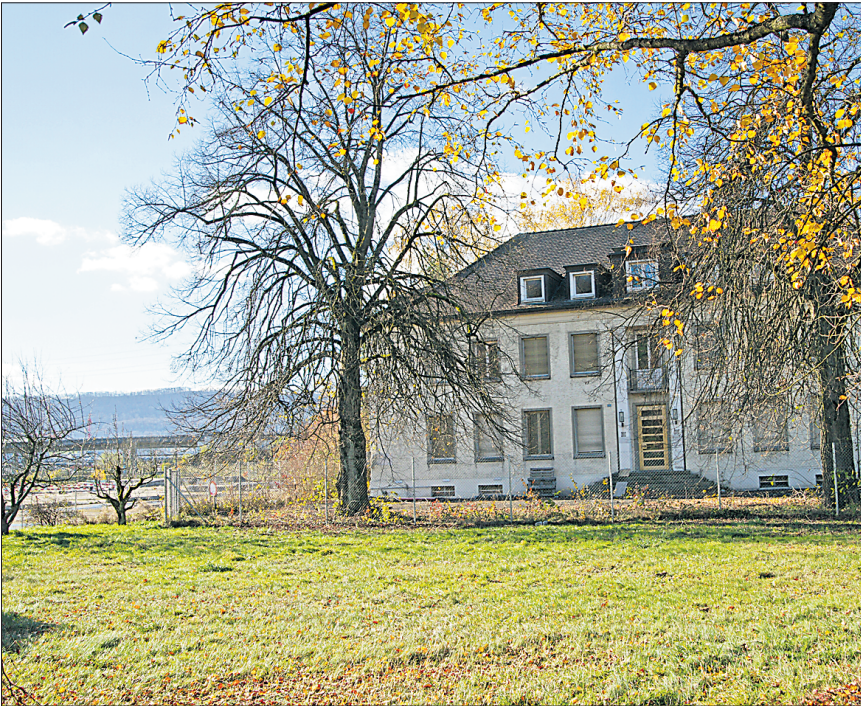
Platz für Menschen, Gewerbe und Industrie hat es genug auf dem Gelände der ehemaligen Reichhold-Chemie. Auf dem Bild das bereits rückbaubewilligte alte Direktionshaus.
