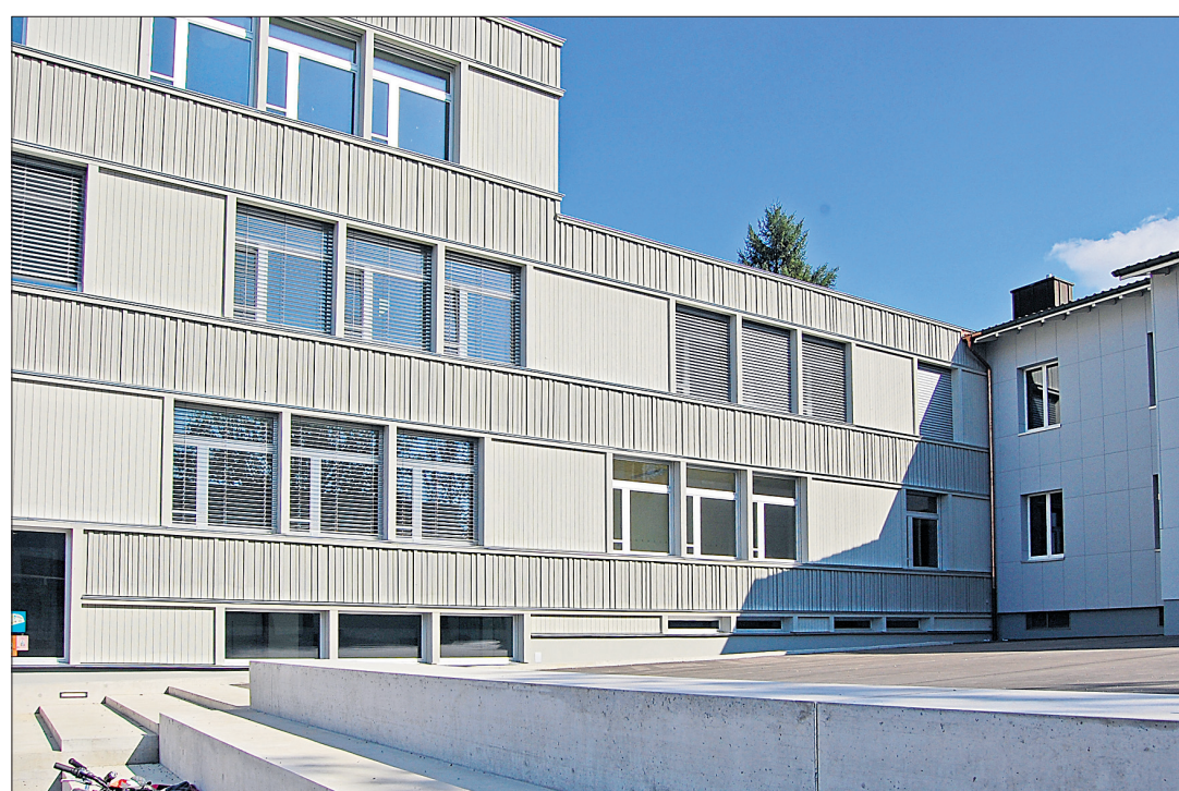
Das neue Lindhofschulhaus verbindet sich mit dem bestehenden Lindhofschulhaus zum grossen Ganzen.
