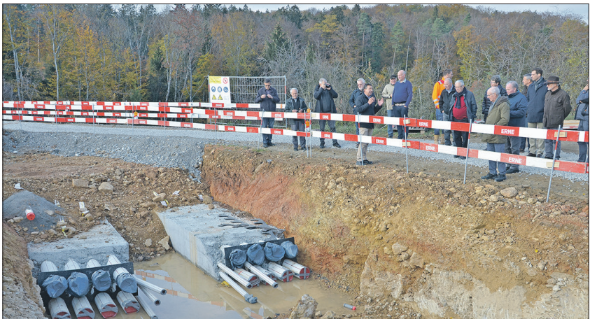
Oben auf dem Gäbihübel: Blick auf bereits erstellte Kabelblockabschnitte mit je sechs Leitungsrohren und je zwei als Reserve vorgesehenen Leerrohren.
