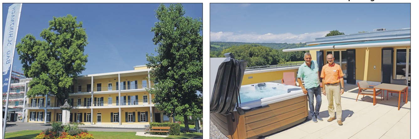
Das neue Haus Habsburg, das (Bild rechts) über eine Dachterrasse mit einzigartiger Aussicht auf Aare und Parklandschaft verfügt: Der Whirlpool quirlt munter, und die schicke Junior-Suite «Habsburg» ist bereit – Udo Drewnowski (l.) und Marcus Rudolf freuen sich, dass das bis 30. September buchbare Eröffnungs-Schnupperangebot von Fr. 299.- pro Nacht für zwei Personen bereits bestens ankommt. Mehr Infos unter www.bad-schinznach.ch/kurhotel-im-park/
