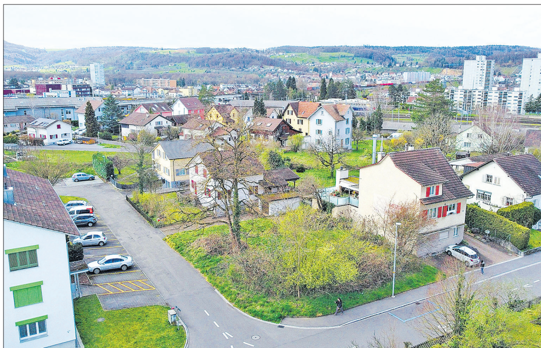
Diese Drohnenaufnahme zeigt den Standort des Bauvorhabens an der Ecke Reutenenstrasse-Mittlere Reutenen.
